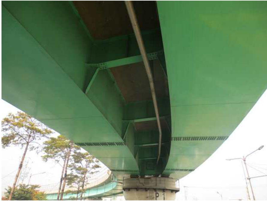
바닥판하면 및 강박스 외부전경
